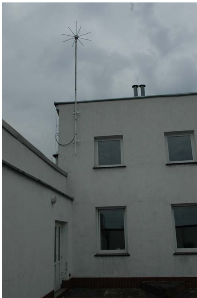
Rys. 4. Instalacja anteny pomiarowej
