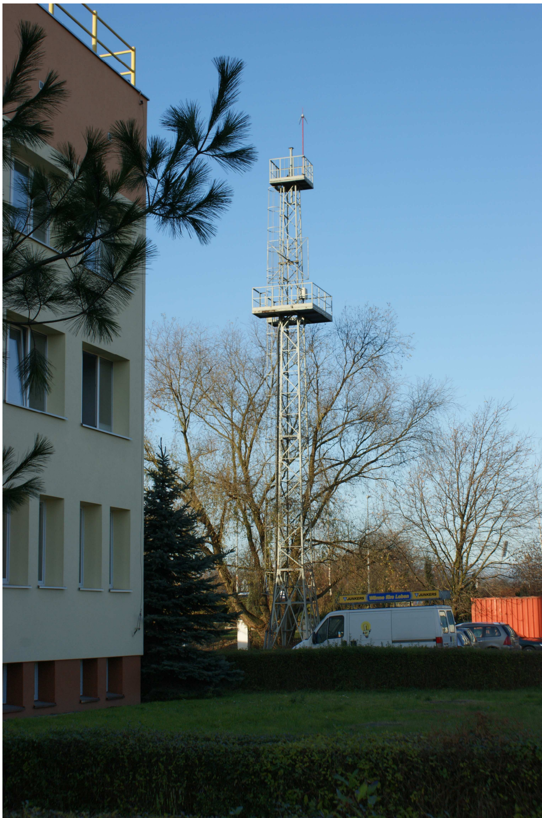
Fot. 2 Wieża nadawcza na terenie Instytutu Łączności we Wrocławiu, na wierzchołku antena nadawcza emisji eksperymentalnej DAB+
